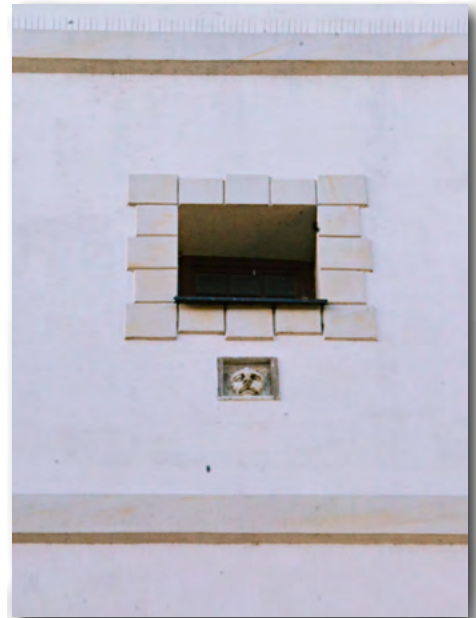
Lew na elewacji wieży bazyliki na Starym Rynku
