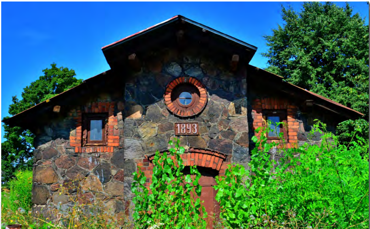
Budynek kamienny z uzupełnieniami z cegły – teren dworca PKP
