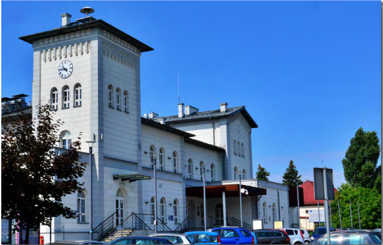
Widok ogólny na dworzec PKP
