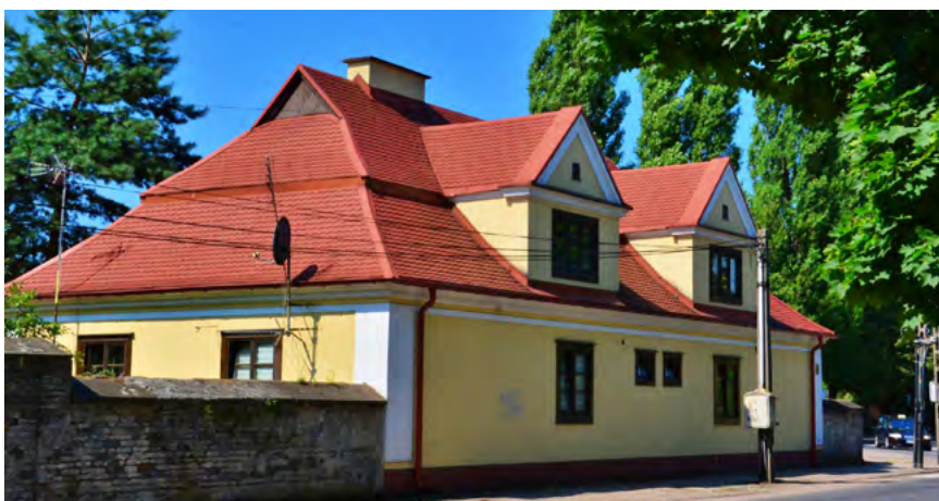
Widok na budynek w duchu romantyzmu narodowego, osiedle przy ul. Rychtelskiego 2
