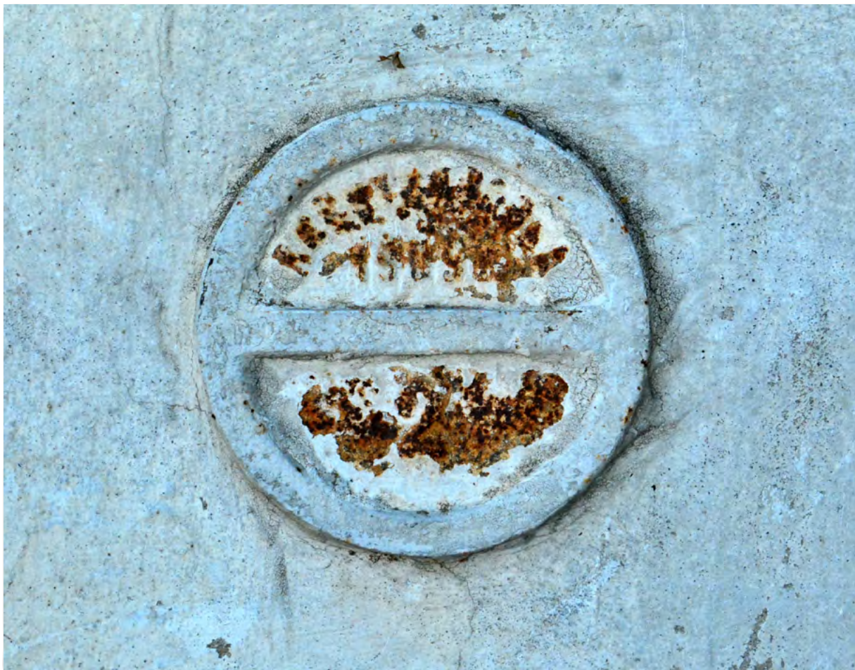
Zbliżenie na reper na budynku przy ul. Sienkiewicza 15
