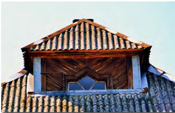
Ozdobne deskowanie półszczytu i nieszablony wykrój okna, osiedle przy ul. Rychtelskiego 2
