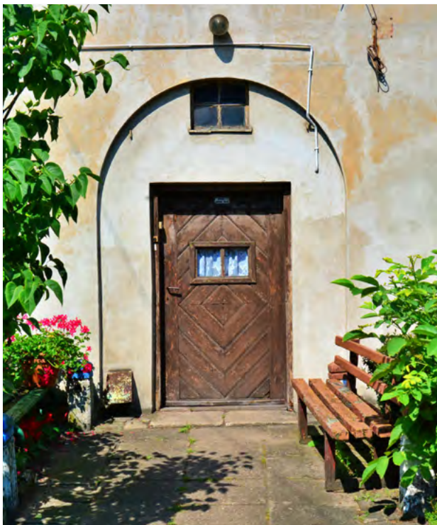
Wejście do budynku prostopadłego do ulicy – ozdobne deskowanie drzwi, osiedle przy ul. Rychtelskiego 2
