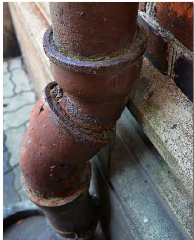
Kolano rury spustowej z sygnaturą Koneckich Zakładów Odlewniczych, kościół św. Wawrzyńca
