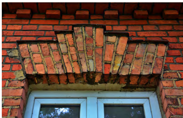
Zbliżenie na szczegóły prac murarskich przy budynku – naczółek okna, ul. 29 listopada 57
