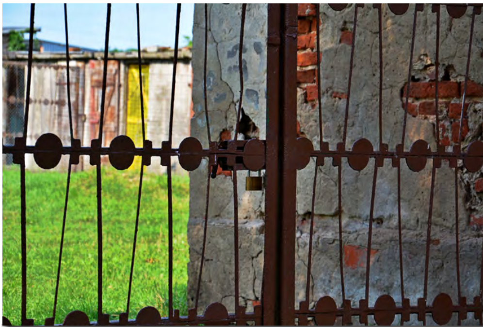
Przykłady ogrodzeń ażurowych z okolic ul. 29 listopada
