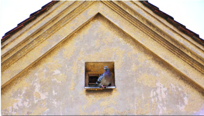
Facjata budynku równoległego do ulicy, osiedle przy ul. Rychtelskiego 2
