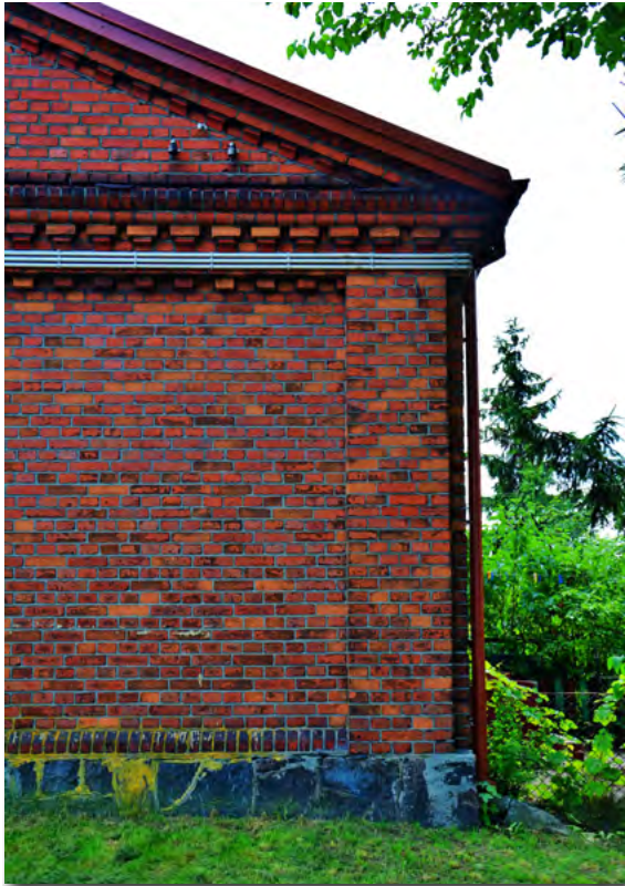
Zbliżenie na szczegóły prac murarskich przy budynku – pas gzymsów, ul. 29 listopada 57
