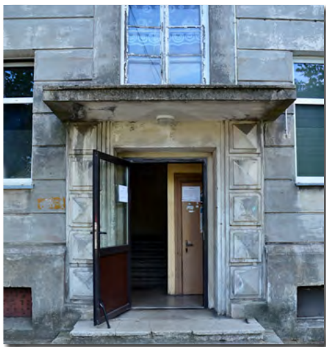
Drzwi obramowane diamentowymi boniami, ul. Okrzei 1
