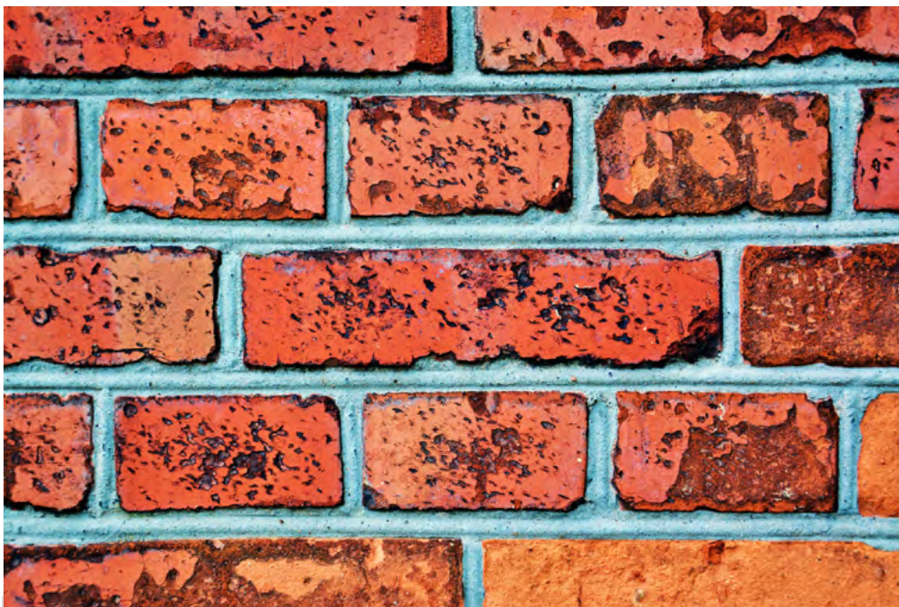
Zbliżenie na szczegóły prac murarskich przy budynku – opracowanie spoin, ul. 29 listopada 57
