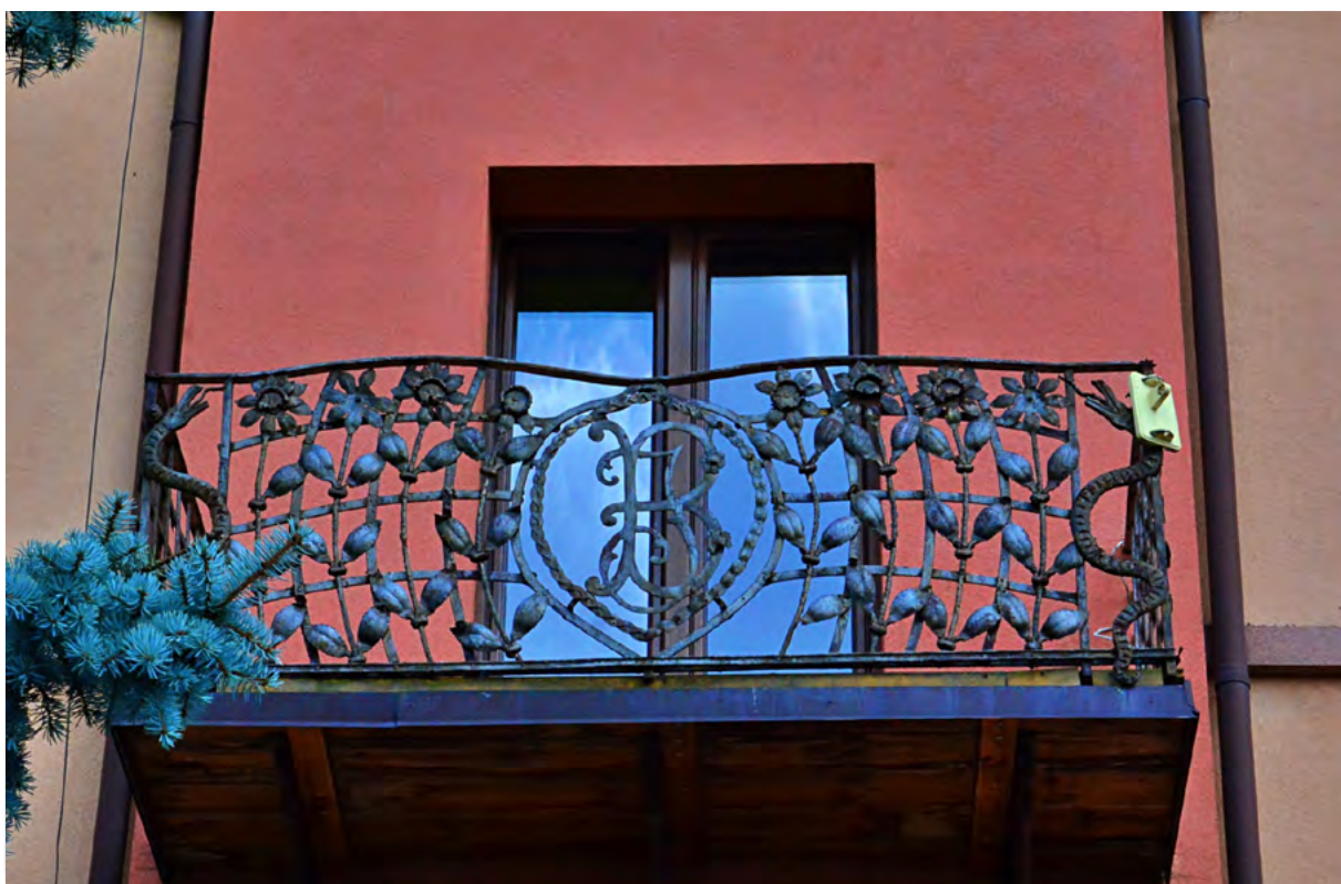
Zbliżenie na balustradę balkonu przy ul. Sienkiewicza 11
