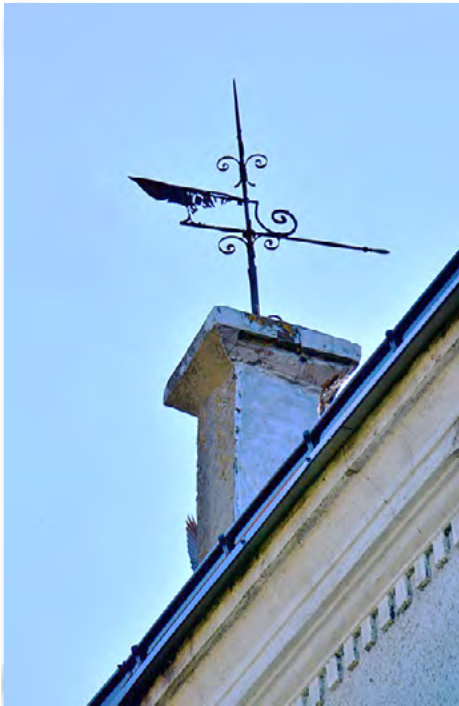
Kamienica przy ul. Pileckiego 1, wiatrowskaz w formie chorągiewki na kutym stelażu
