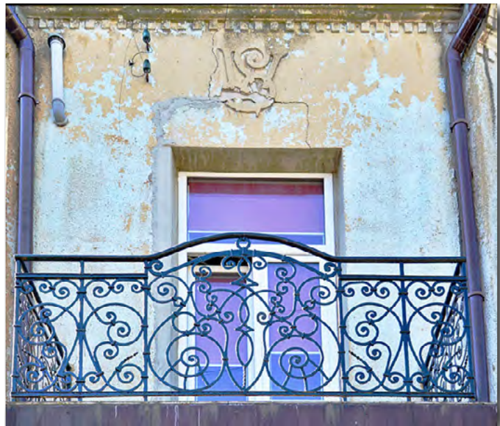
Kamienica przy ul. Pileckiego 1, zbliżenie na kąt balustradę balkonu
