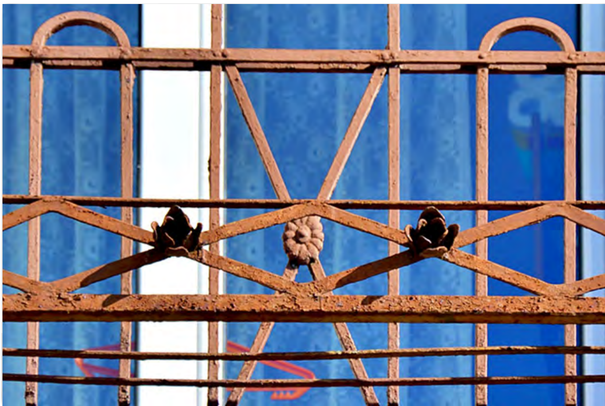
Kamienica przy placu Narutowicza 20, zbliżenie na balustradę balkonu
