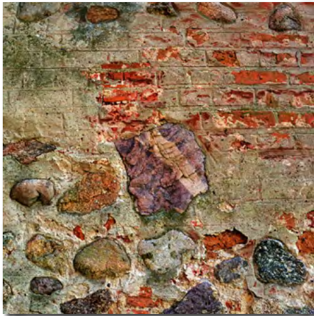
Detale Grocholic, zbliżenie na ścianę kościoła pw. Wszystkich Świętych
