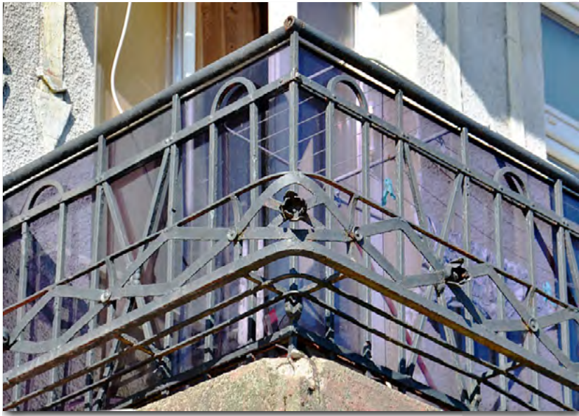
Kamienica przy placu Narutowicza 20, zbliżenie na obejmę na skrzynki z roślinami
